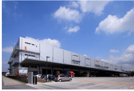
【IIF野田ロジスティクスセンター (産業ファンド投資法人)】 / CASBEE、DBJ Green Building認証、BELS
