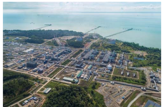
液化プラント既存第2系列および 建設工事中の第3系列、LNGタンク、栈橋等
