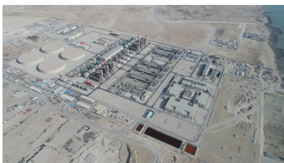
カタール Umm Al Houl Power
