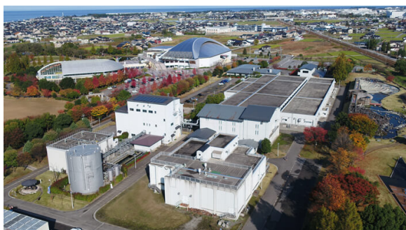
黒部市下水道バイオマスエネルギー利活用施設
