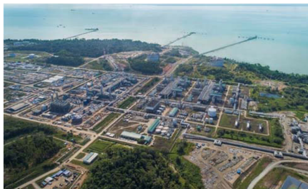
液化プラント既存第2系列および建設工事中の第3系列、LNGタンク、栈橋等
